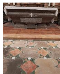
PAVIMENT DE MARBRE
