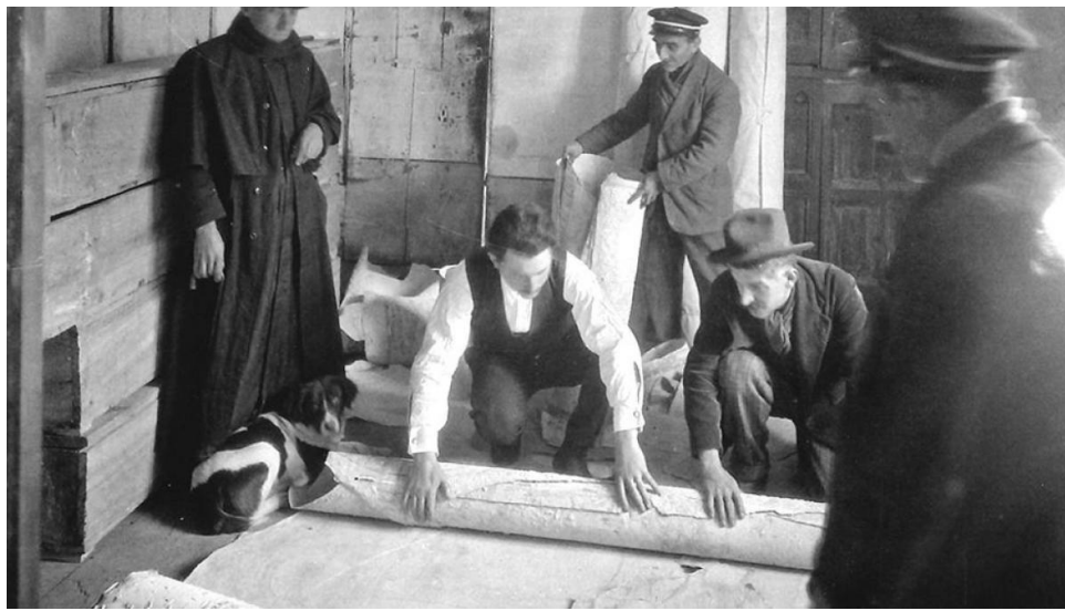
Els operaris enrotllen una de les pintures murals ja arrencades amb aquesta la tècnica en una església romànica dels Pirineus
