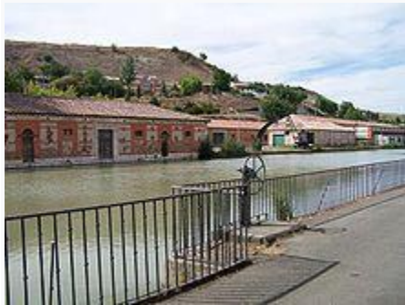
Canal de Castella, dàrsena del Canal de Castella de Valladolid.
